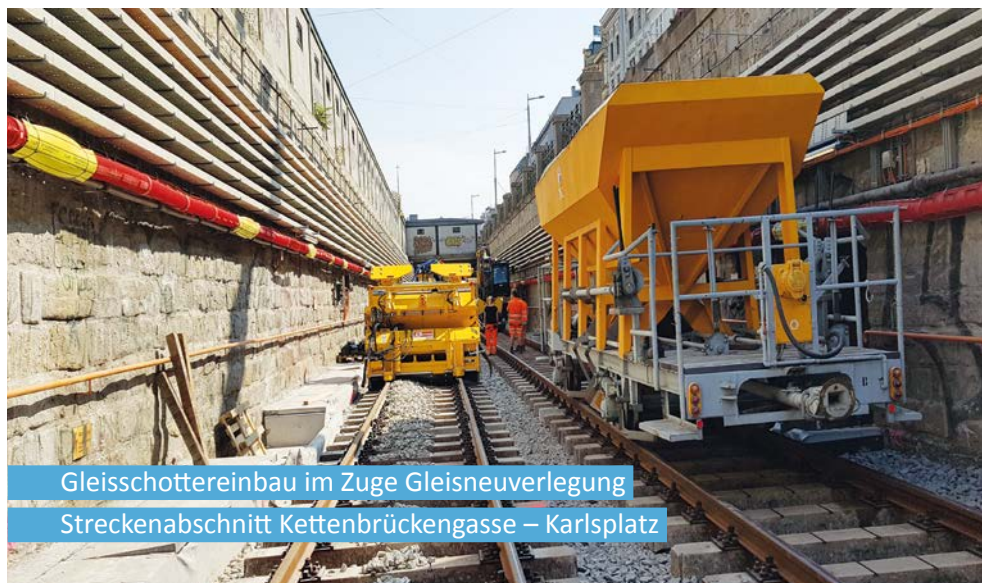
Abbildung 2: Baumaßnahmen für die Modernisierung der Linie U4
