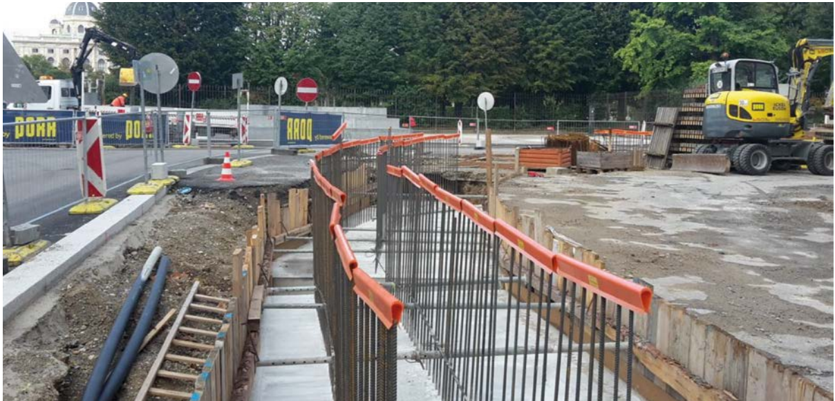
Abbildung 3: Fundament mit Bewehrungseisen im Bereich des Bundeskanzleramts zum Zeitpunkt des Baustopps
