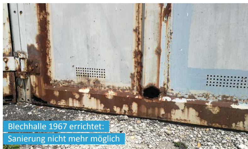
Abbildung 14: Außenwand der Panzerhalle
