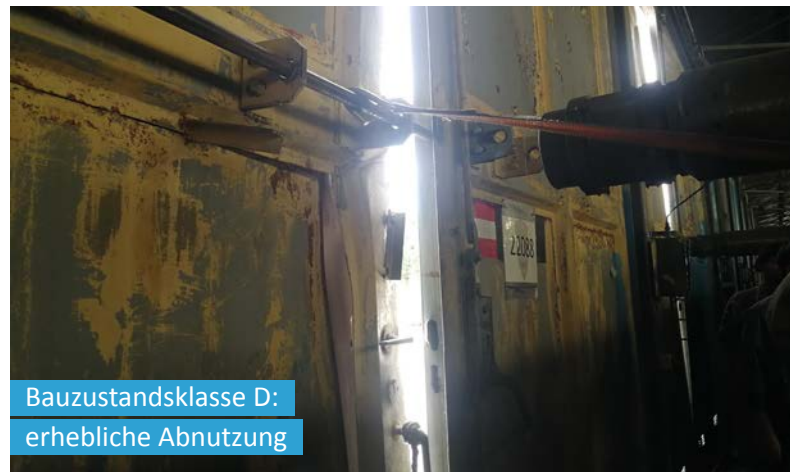
Abbildung 13: Defektes Tor
